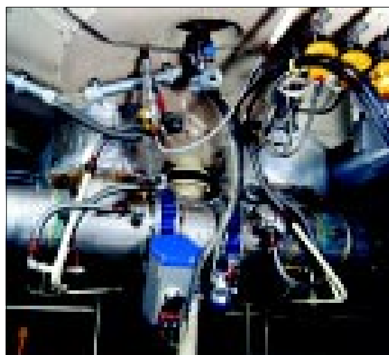
Rys. 5. Przepustnica RS DN 350 z wymienną uszczelką i z pneumatycznym napędem Revo (usytuowanie: wylot z warnika na przejściu do następnego warnika)
